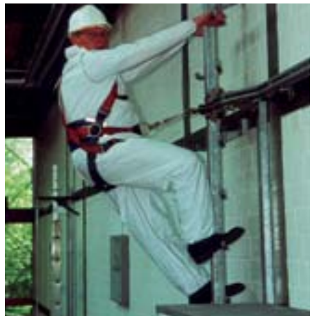
Bild 2-28: Weiche in der festen Führung eines mitlaufenden Auffanggerätes
