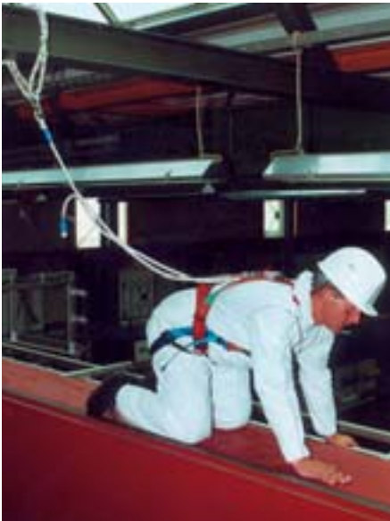
Bild 2-11: Verbindungsmittel mit Reibungsfalldämpfer
