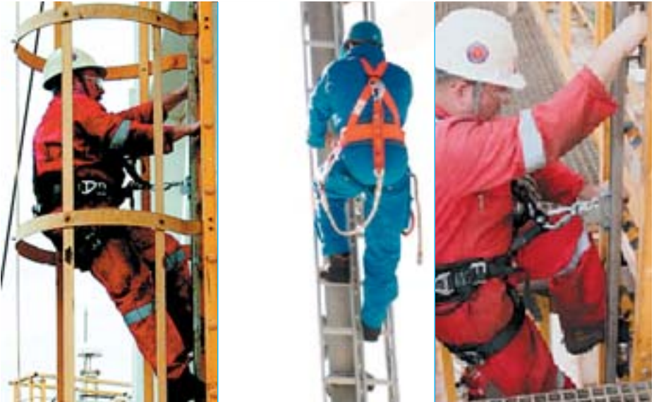
Bild 2-27: Verbindungsmittel maximal 300 mm lang (Maßstrecke beginnt (links) an der Vorderkante der Schiene)
