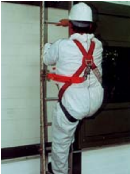
Bild 2-29: Mitlaufendes Auffanggerät an beweglicher Führung mit Bandfalldämpfer
