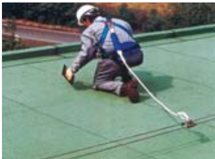
Bild 2-18: Anschlageinrichtung als horizontale Führung
