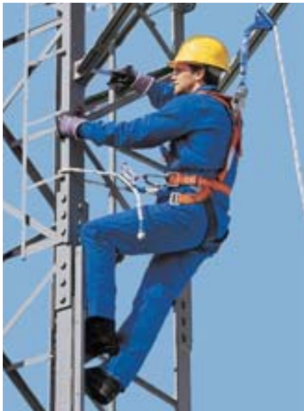
Bild 2-35: Kombination aus Auffanggurt (hier an einem mitlaufenden Auffanggerät an beweglicher Führung) und Haltegurt (mit einkürzbarem Verbindungsmittel)
