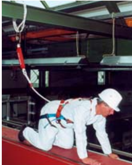
Bild 2-12: Verbindungsmittel mit Bandfalldämpfer
