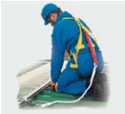
Bild 2-18: Anschlageinrichtung als horizontale Führung
